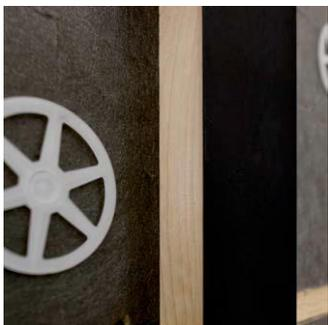
Die vertikale Traglatten müssen mit einem UV-beständigen EPDM-Band geschützt werden. Dieses Band muss die Traglatte vollständig überdecken und an beiden Seiten mindestens 5 mm überstehen. Die Heftklammern sind nicht im Bereich der Tafelfugen anzuordnen.
