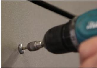
Die Tafelbefestigung erfolgt von innen nach außen. Ein Überdrehen der Schraube ist zu vermeiden, da es sonst zu Oberflächenbeschädigungen der Tafeln kommen kann.
