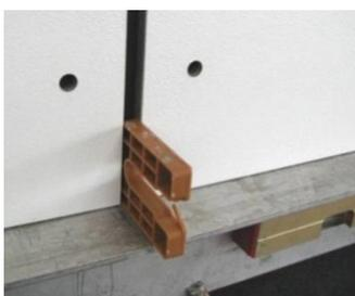
Zur Ausrichtung der nächsten Fassadentafeln in horizontaler Richtung kann ein 10 mm Abstandhalter verwendet werden, um ein gleichmäßiges Fugenbild zu erhalten.
