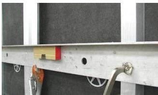
Die vorgebohrte Tafel wird auf einen horizontal ausgerichteten Richtscheit gestellt, gegen die Unterkonstruktion gelehnt und korrekt ausgerichtet.
